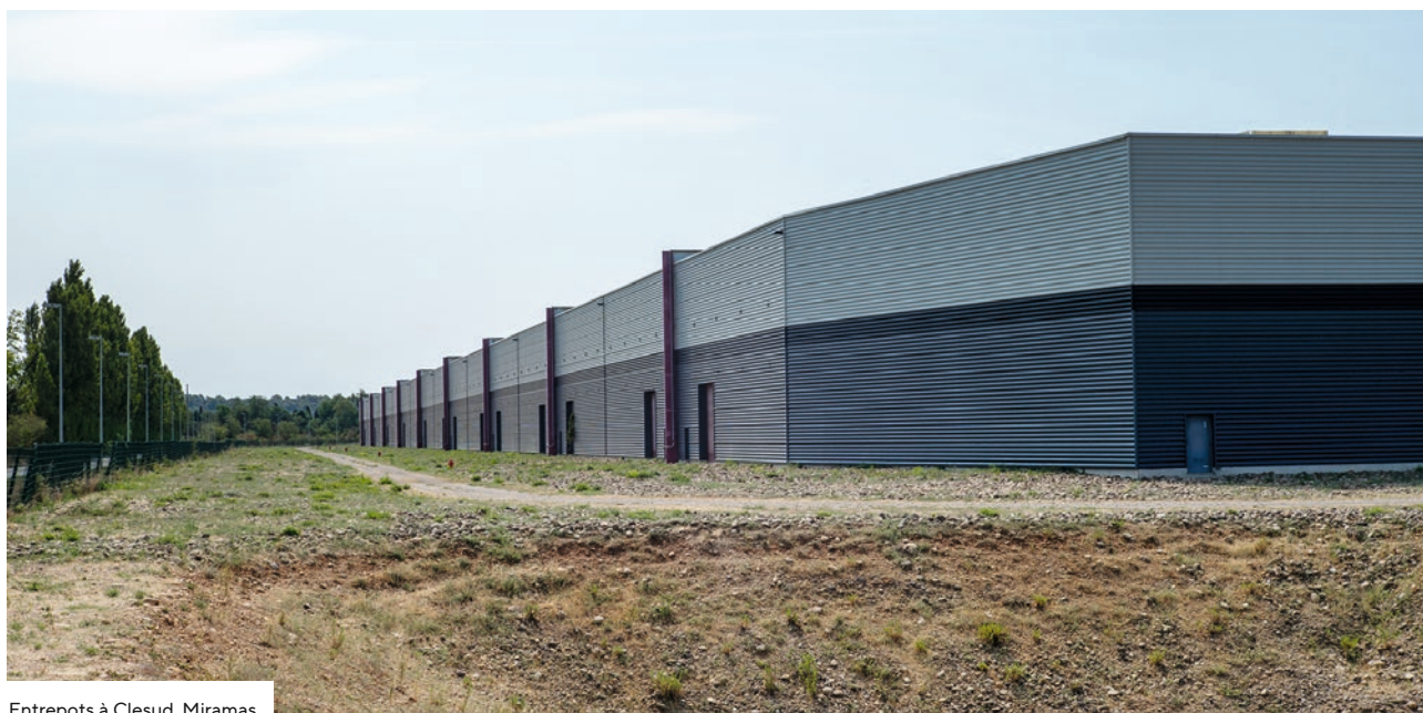
Entrepôts à Clesud, Miramas
