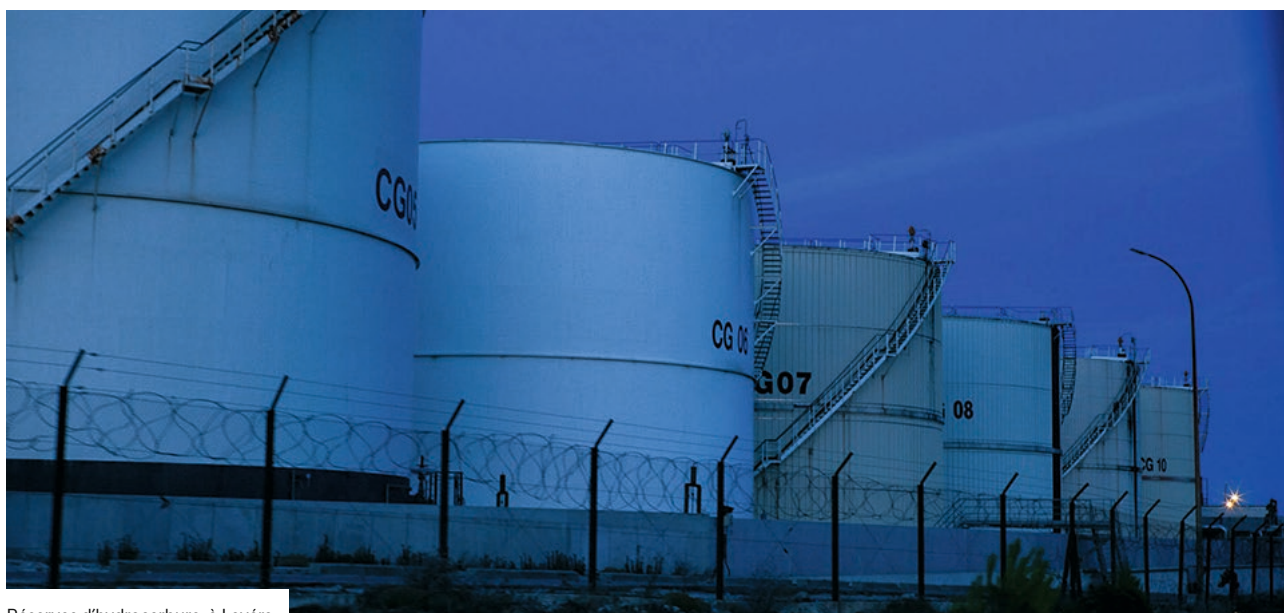
Réserves d'hydrocarbure, à Lavéra
