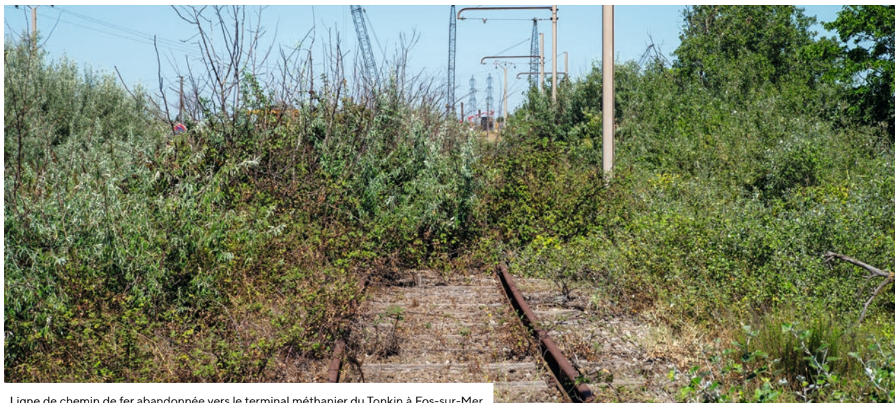
Ligne de chemin de fer abandonnée vers le terminal méthanier du Tonkin à Fos-sur-Mer
